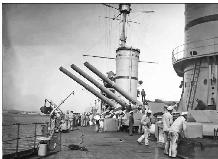
«Полтава» на Гельсингфорском рейде в середине 1916 г. На этом линкоре лебедки и стрелы для погрузки угля так и не были установлены, хотя ролики для проводки тросов имелись. Только на «Полтаве» внизу кожухов обеих труб с зимы 1914/15 г. до зимы 1916/17 г. был ряд овальных отверстий
