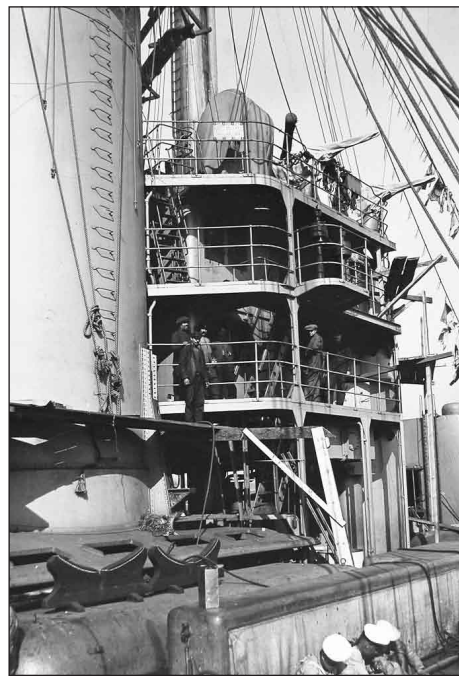
«Гангут» на достройке в конце лета 1914 г. Все площадки надстройки примыкают к трубе одинаково. Прожектор установлен непосредственно на палубу верхней площадки надстройки, рядом две 47-мм салютных пушки. На выступающей площадке на среднем ярусе надстройки находятся посты управления прожекторами
